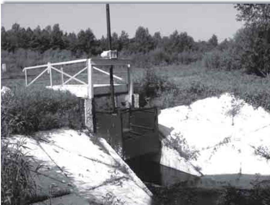
Труба-регулятор с ковшевым затвором, Булев Мох
